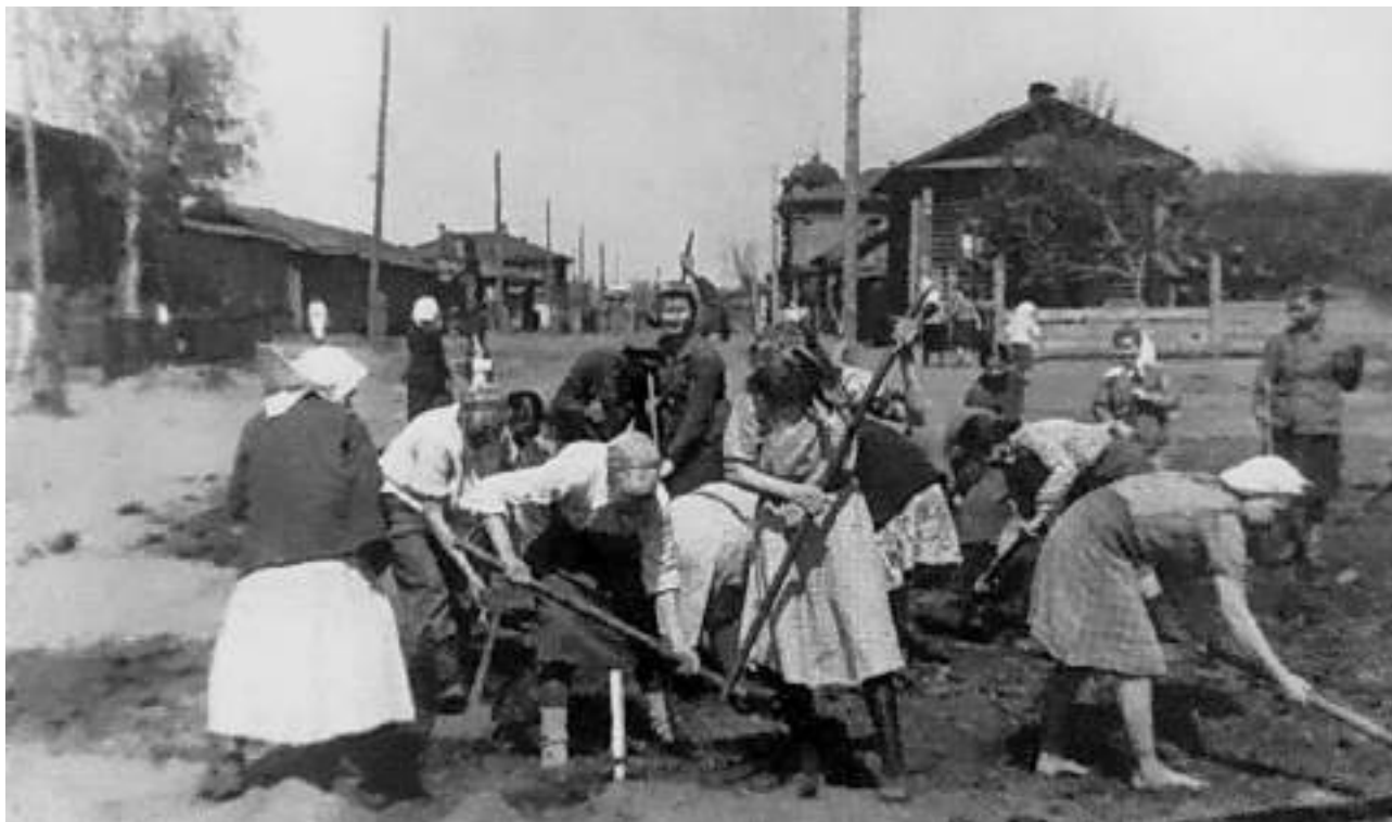
Участники воскресника на засыпке траншеи водопровода
